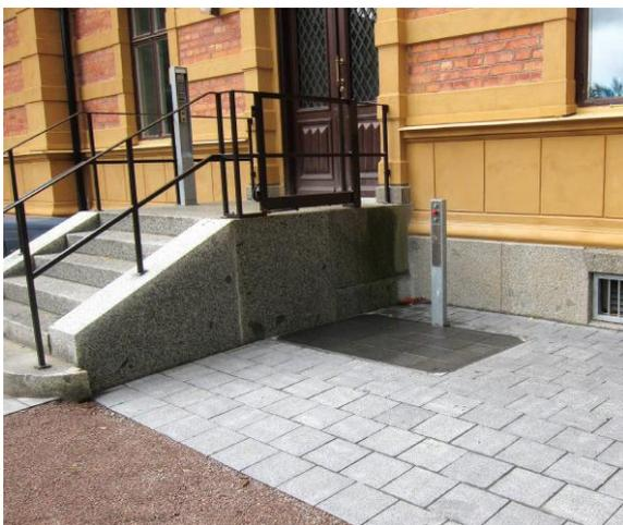
Abbildung 94: Hebeplattform. Im Ruhezustand nahezu kaum sichtbar, Quelle: [www.stepless.com](http://www.stepless.com)
