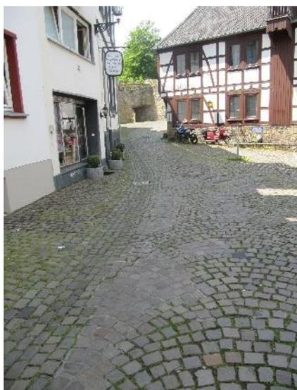
Abbildung 77: Fehlende Trennstreifen zwischen Geh- und Fahrbahn
