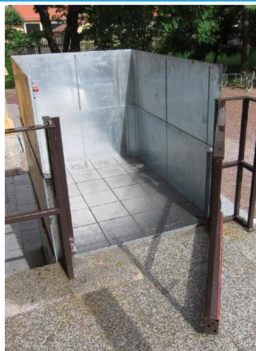
Abbildung 93: Hebeplattform im Umgang mit Barrieren, Quelle: [www.stepless.com](http://www.stepless.com)
