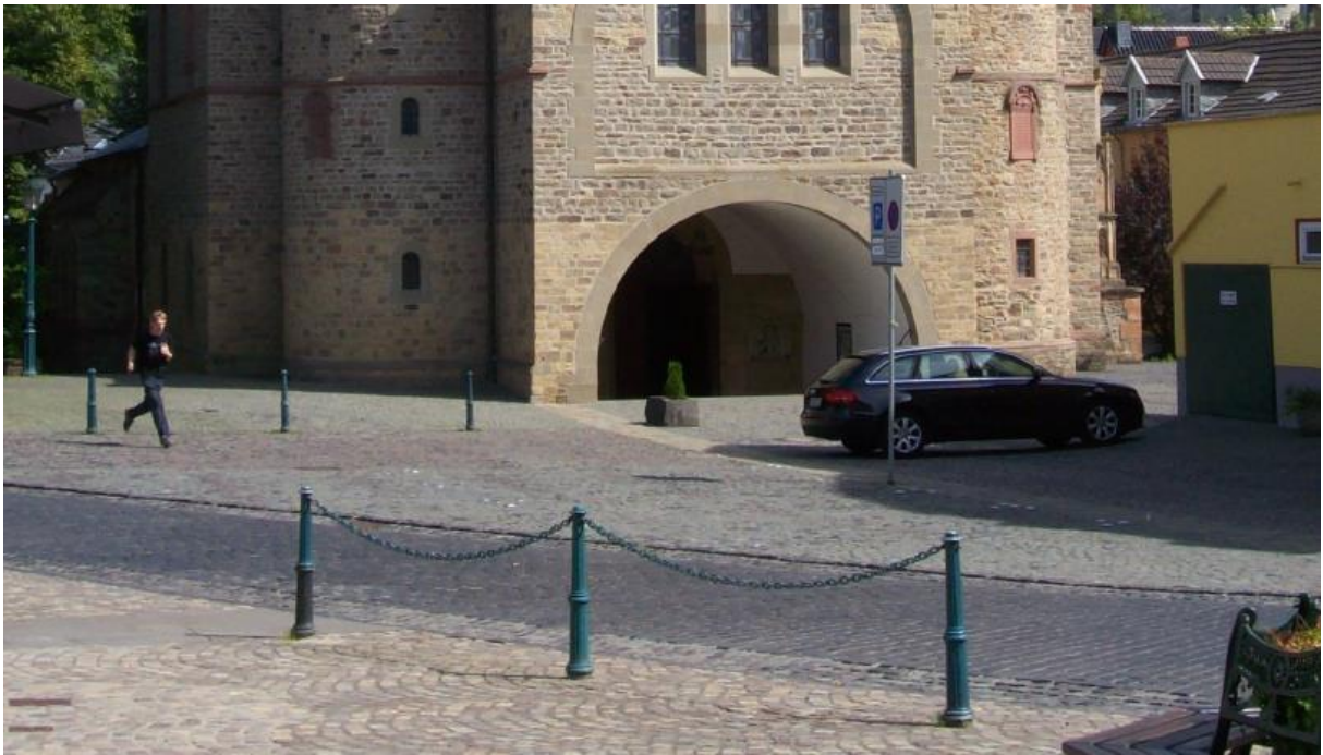
Abbildung 25: Historisierender Straßenbelag auf dem Streckenzug Langenhecke
