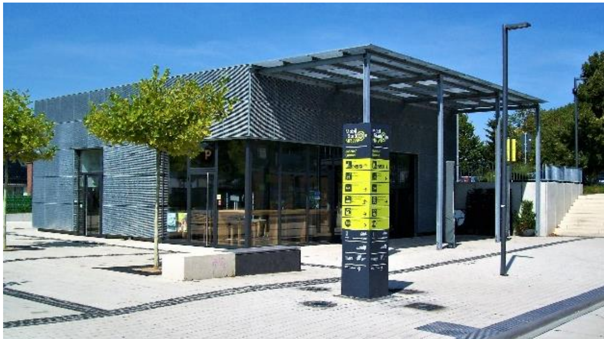
Foto: Beispiel Mobilstation Erftstadt Bf
